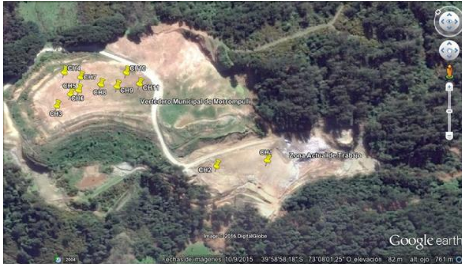
Figura 13 Ubicación de chimeneas utilizadas para la caracterización del biogás emanado. Fuente: Elaboración Propia
