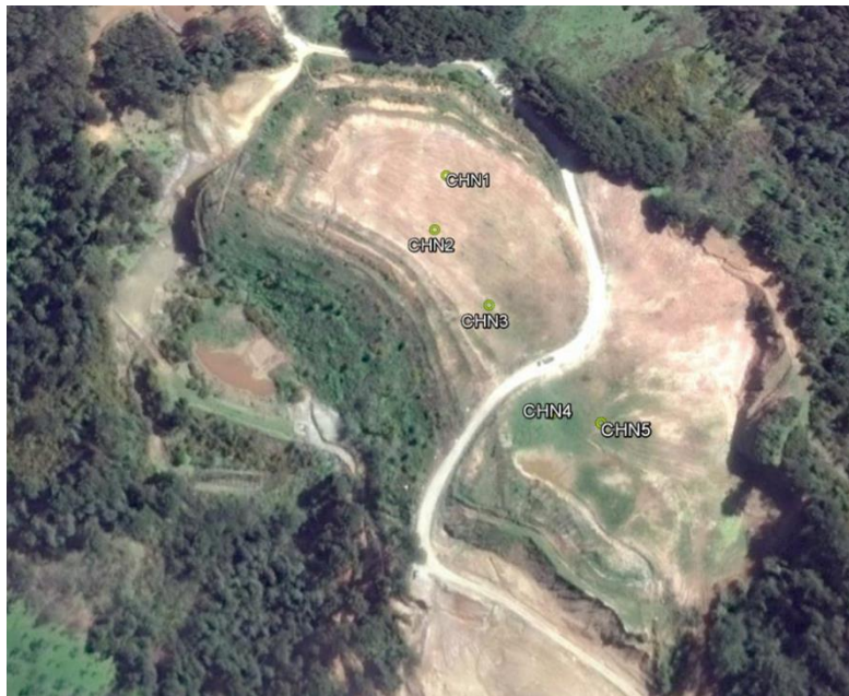
Figura 24 Ubicación de las chimeneas construidas en el Vertedero Morrompulli
